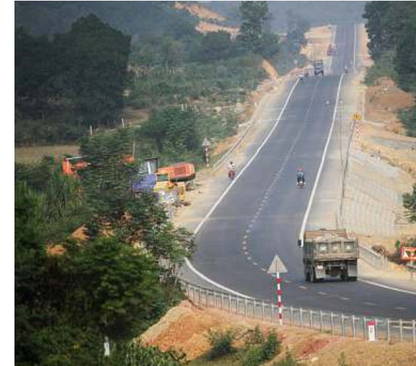
Cao tốc Hòa Lạc - Hòa Bình
